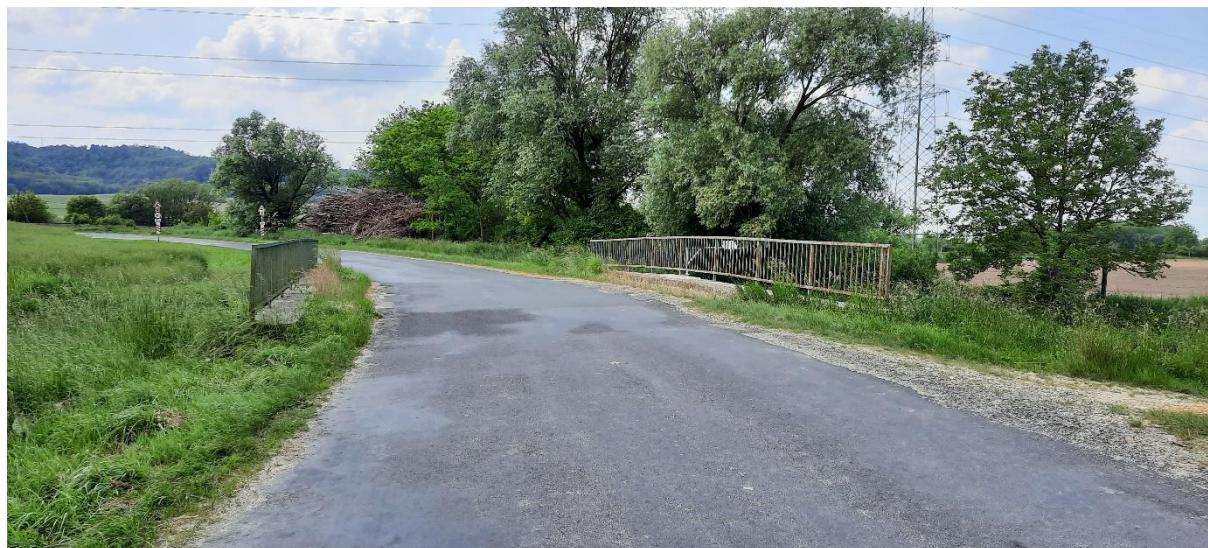
A Szévíz-patak hídja a 73224 j. ök. úton
